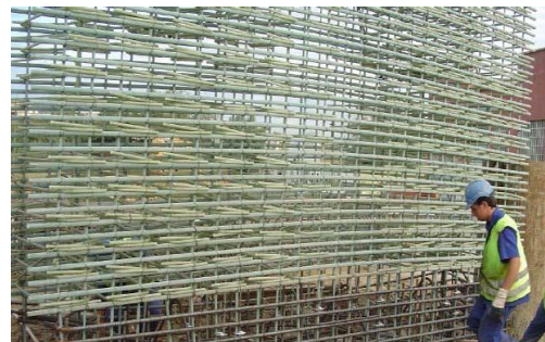
(d) Soft-eye reinforcement for a diaphragm wall
