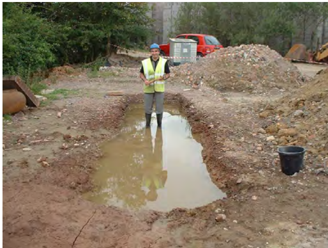
Fig. (20). “inspecting” the CLSM pour.
